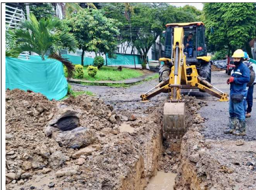
Foto 4. Trabajo en obra
