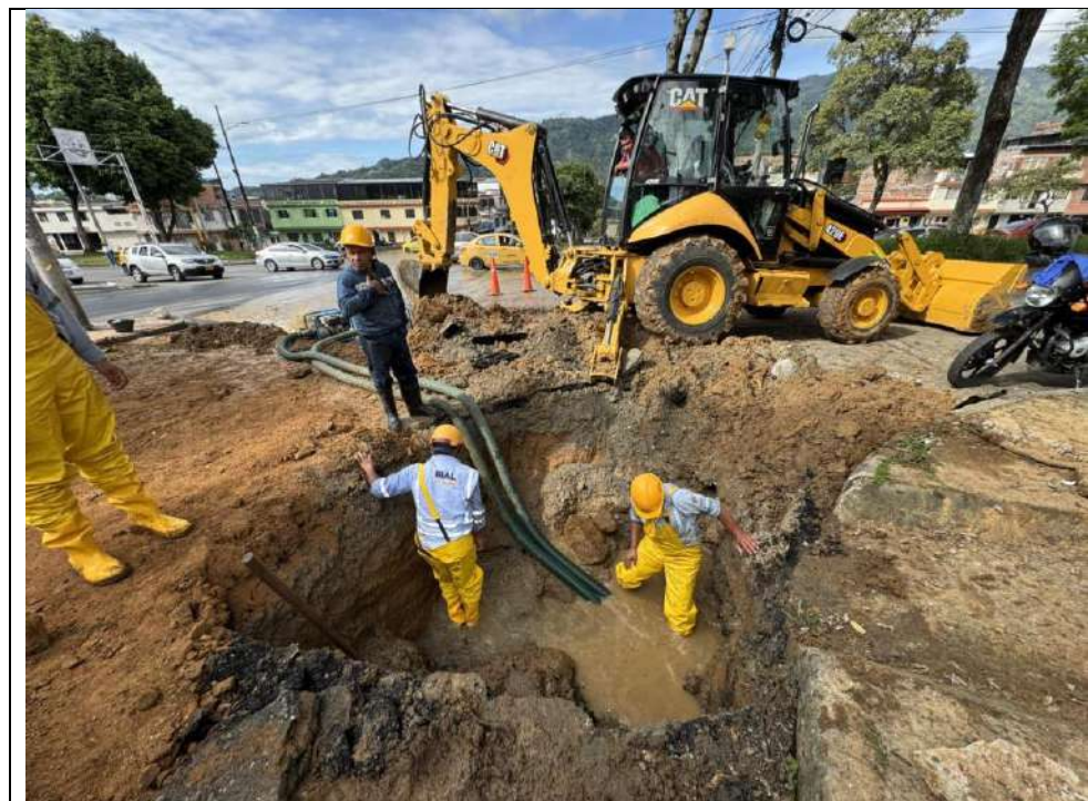
Foto 1. Excavaciones en conglomerado
