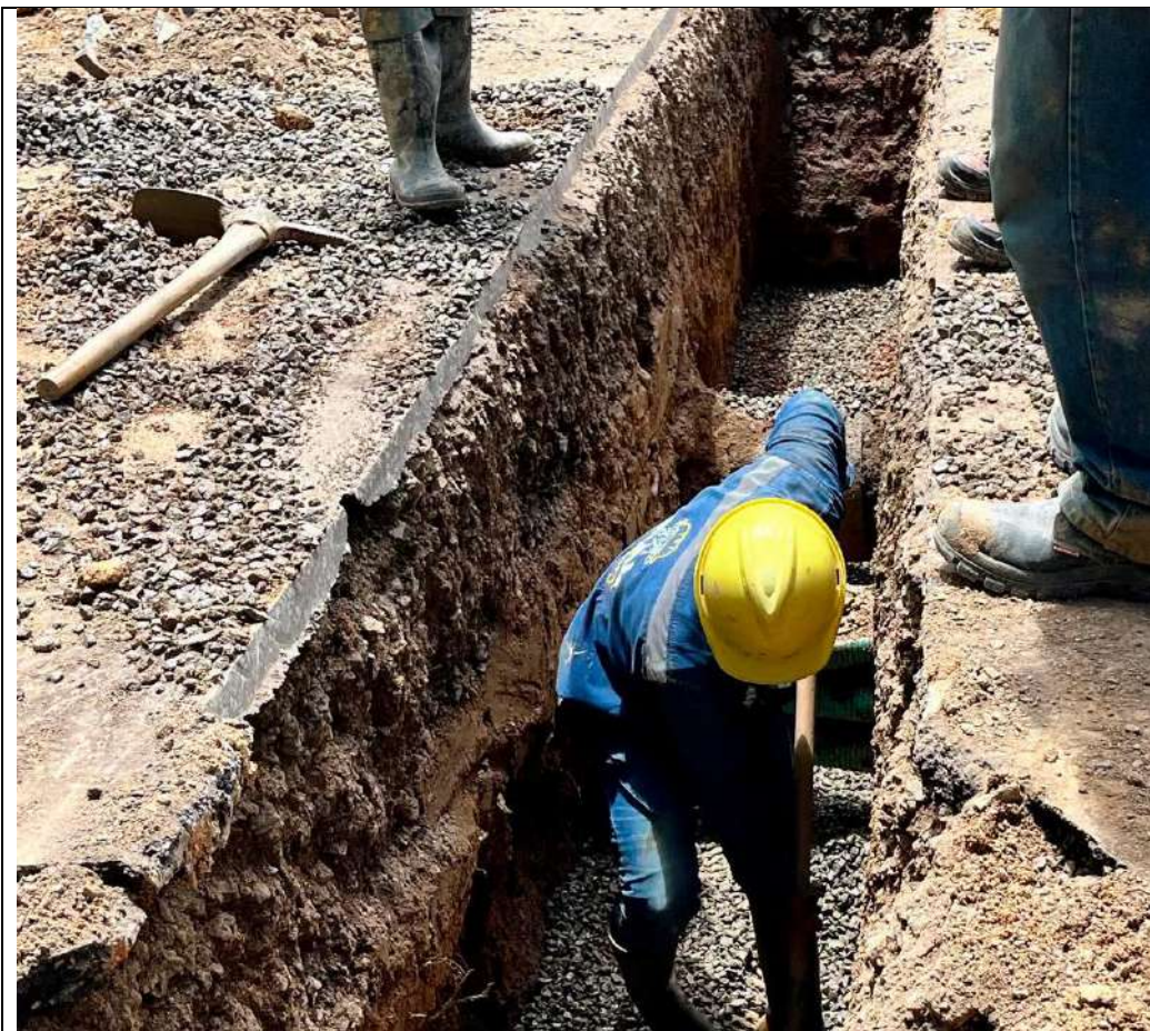
Foto 2. instalación de la tubería
