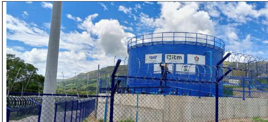
Foto 3. Tanque de Almacenamiento
